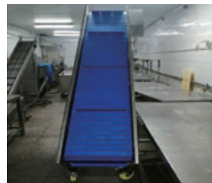
提升機已安裝完成
